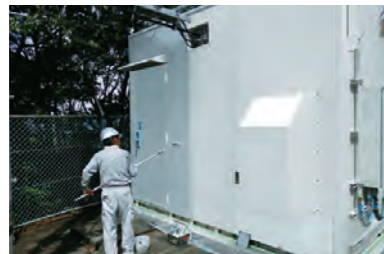
17 シェルター全面改修
