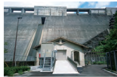
12 水力発電所用(電気室)
